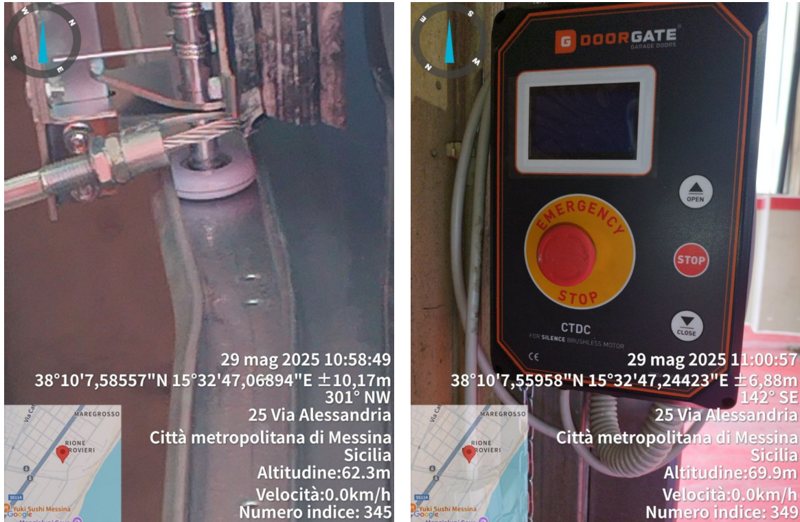
Foto 2 e 3: particolare del sistema di guida con ruote in teflon e centralina di comando
